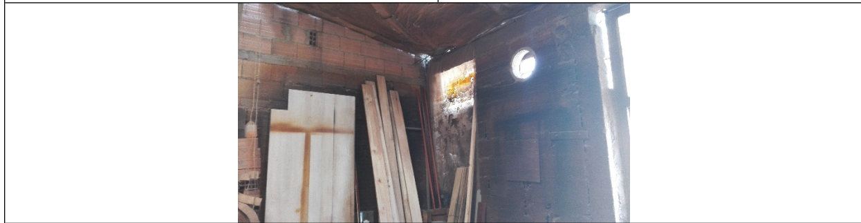
Foto 3: Área desmantelada de pintura
